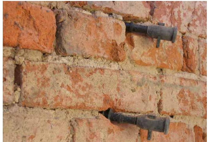
Einsatz von Lamenschlagpacker mit Verschlussstück | Utilisation d'un injecteur lamellé à enfoncer avec obturateur à curseur transversal
